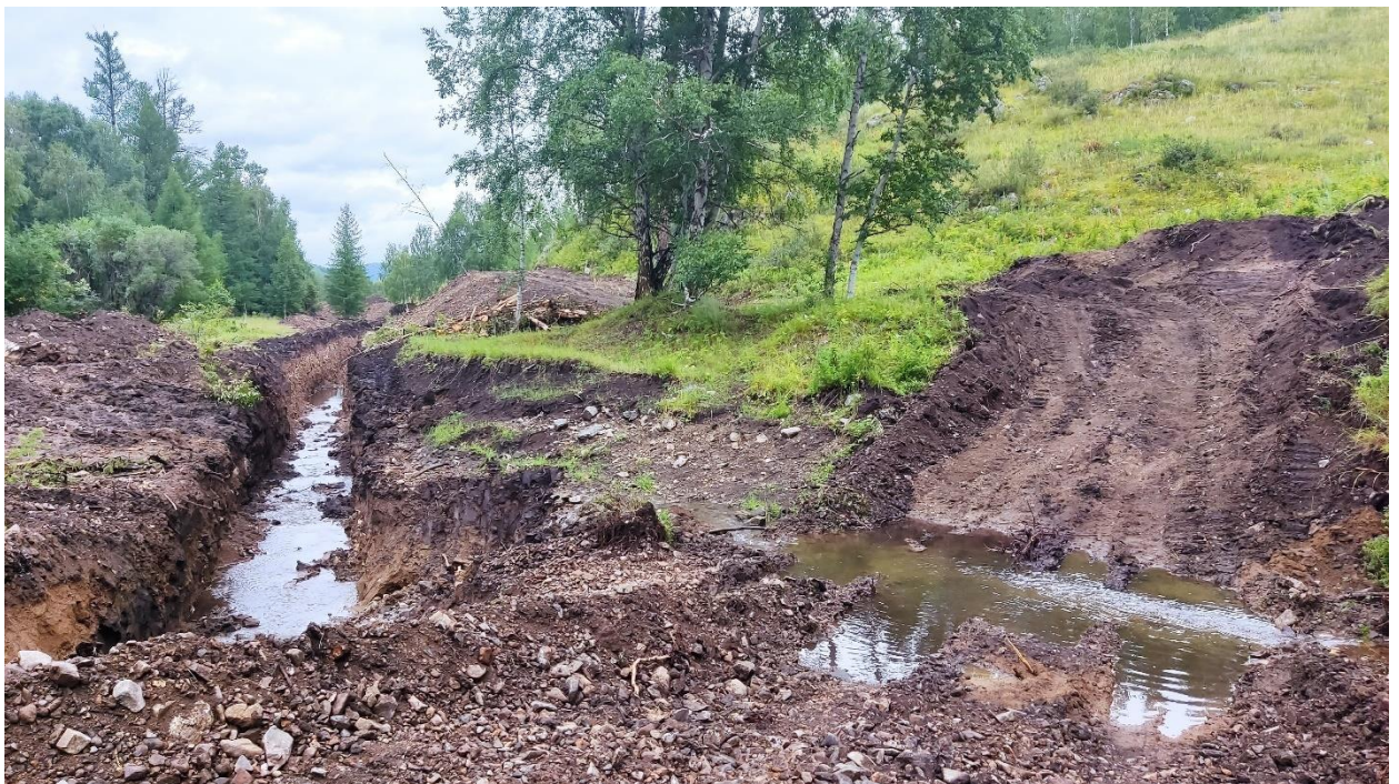
Фото 14. Траншея перед участком золотодобычи и ручей.
