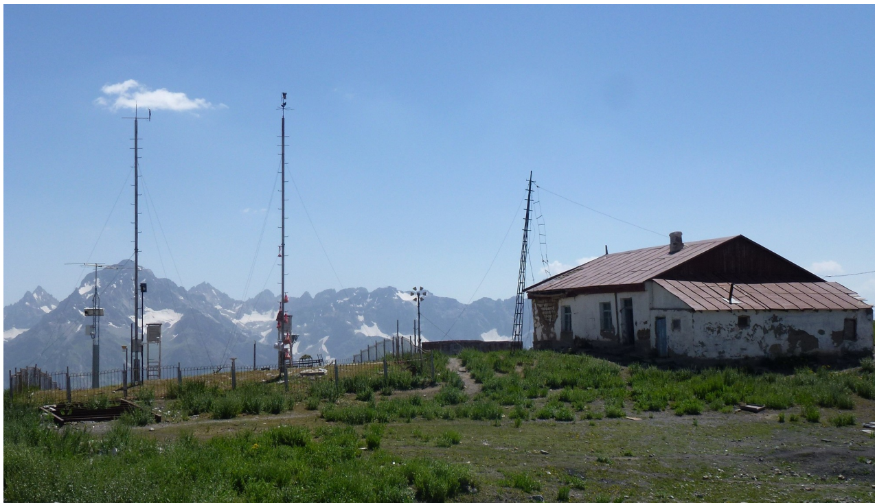
Метеостанция на Анзобе
