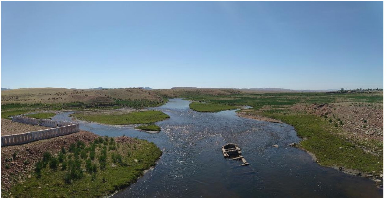
Фотография ПЗ.29 – Вид с моста через реку Уйбат в п. Весеннее
