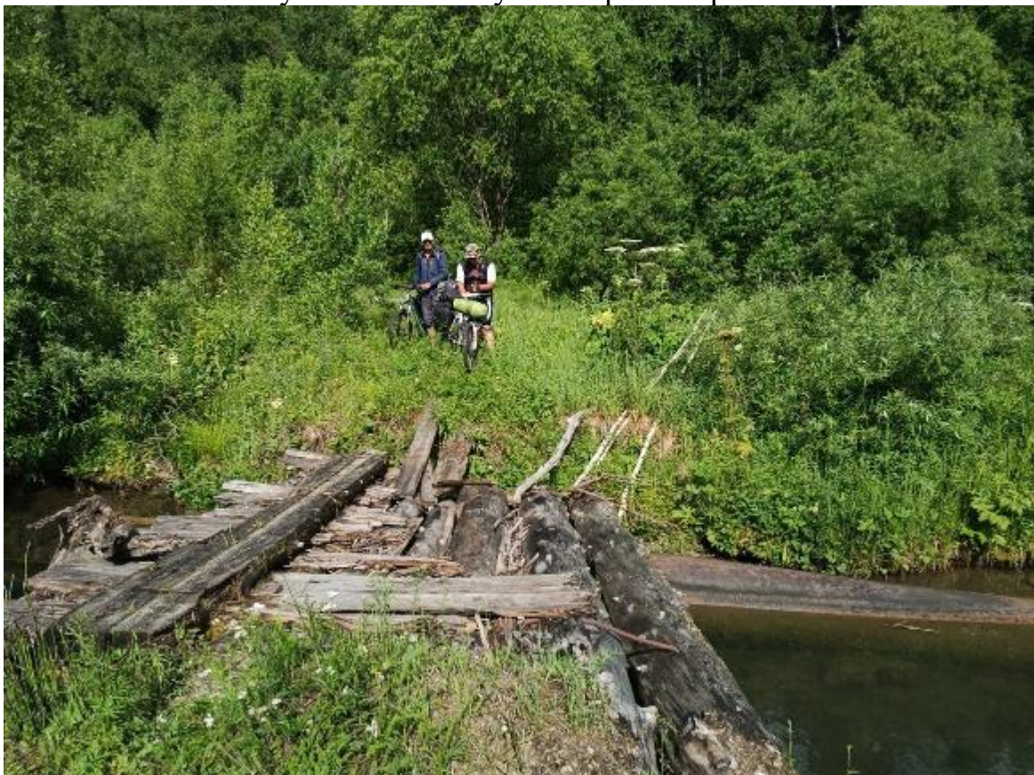
Рисунок ПЗ.19. Мост через р. Киза
