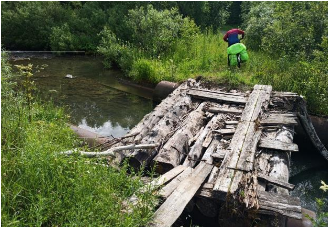
Рисунок 2.26. Участок ПП5 (мост через р. Киза)
