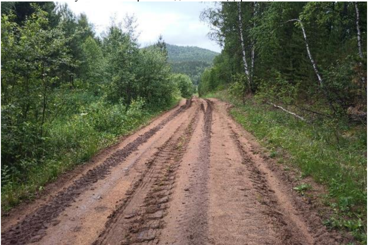
Рисунок 2.49. Первый подъём ПП8. Дорога вдоль ВЛ.
