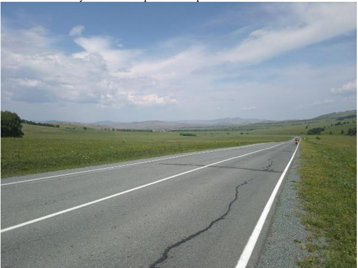
Рисунок ПЗ.94. Трасса в направлении пгт. Аскиз.
