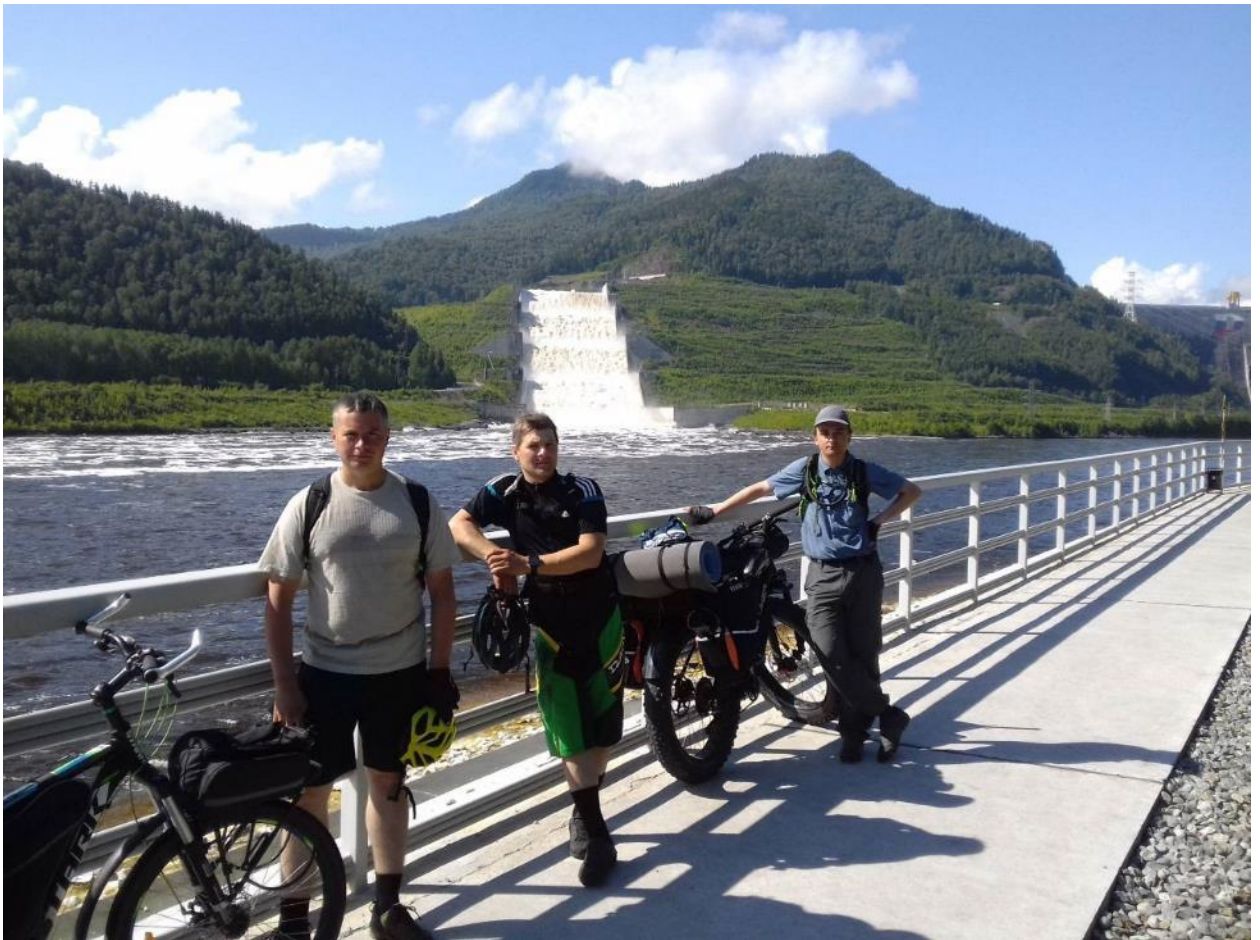
Рисунок 11. Вид на береговой водосброс СШ ГЭС
