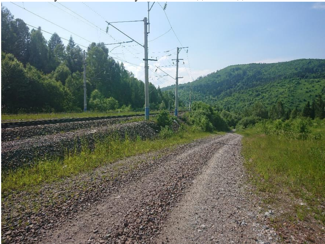
Рисунок 82. Спуск от западного портала тоннеля в сторону ст. Бискамба
